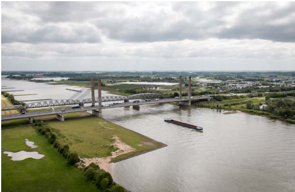
De Martinus-Nijhoffbrug over de Waal
